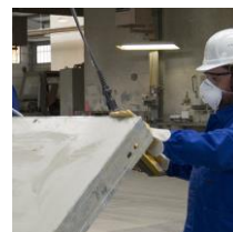
Limpieza de encofrados
