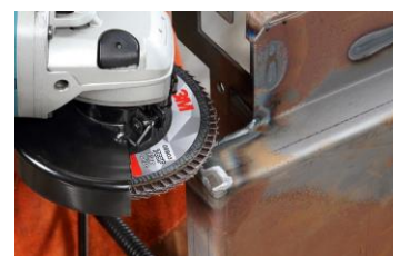
Limpieza de soldaduras
